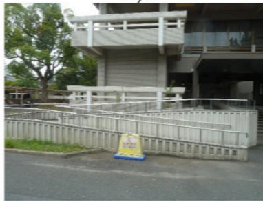
A棟前スロープ
