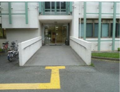
N棟出入口
