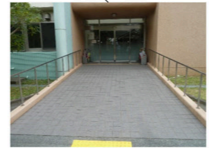
S棟出入口
