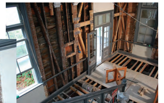
耐震改修工事中の館内の様子
