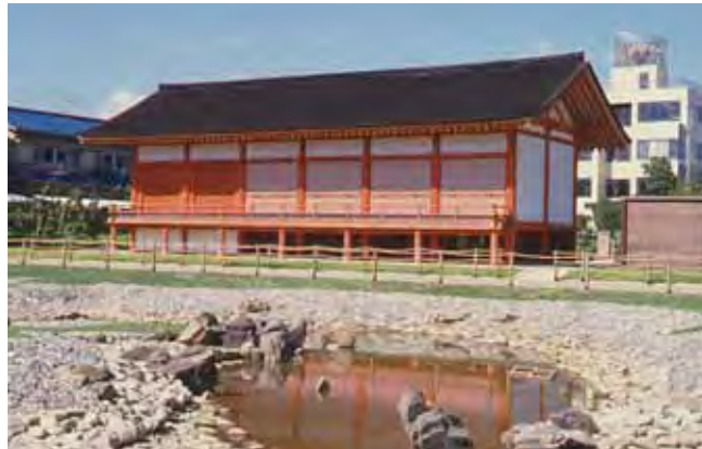
■北東から園池、復原建物を望む
