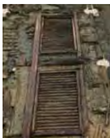
■山田寺回廊出土状況
