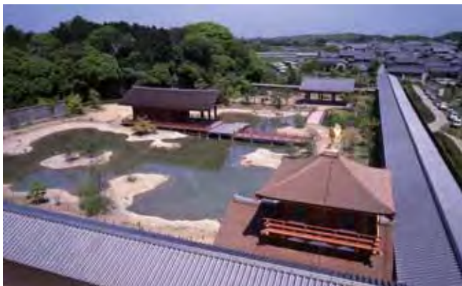
■東院庭園全景
