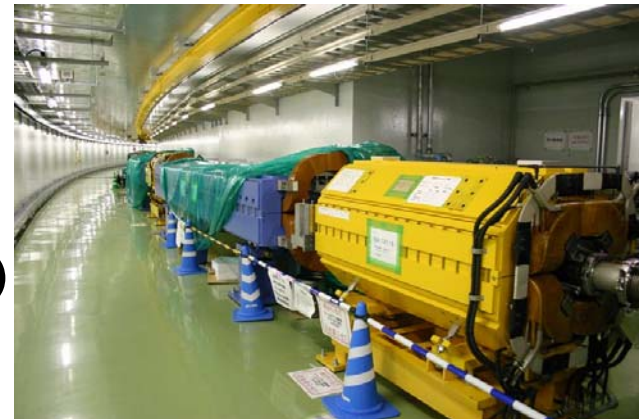
50GeV加速トンネル内電磁石
